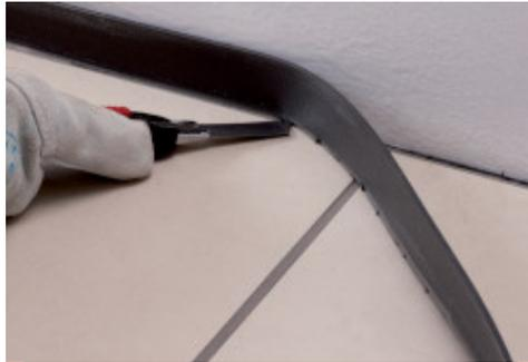
Une fois que le mortier de jointoiement a durci, ébarber le périmètre de la bande Mapesonic Strip pour retirer l'excès de matière.
