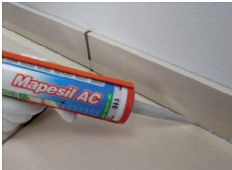
Sceller l'interstice entre les plinthes et le sol à l'aide d'un mastic flexible approprié de la gamme Mapei.
