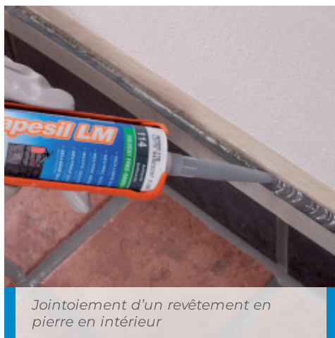
Sceller un joint de façade avec Mapesil LM
