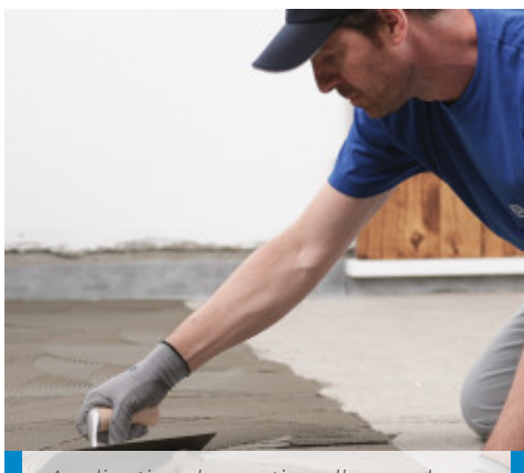
Application du mortier colle avec la spatule dentée n° 5
