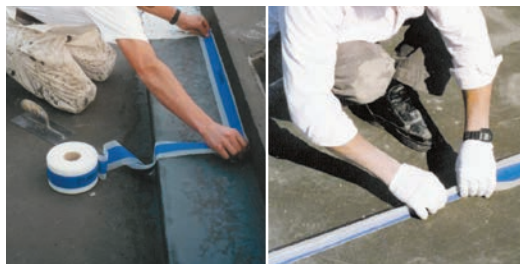
Exemple d'utilisation de Mapeband pour l'imperméabilisation d'un coin situé entre le bas et le côté d'une baignoire
