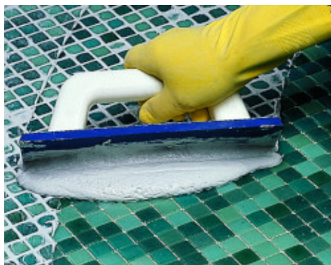
Jointoiement de pâte de verre avec Keracolor FF mélangé avec Fugolastic
